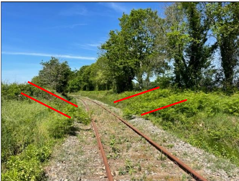
Figure 3 : Photo de l'ancien PN 18 au PK 9+981 en date du 10/05/2022
